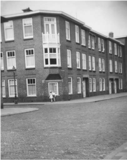
Op 1 februari 1953 kwamen wij te wonen in de 1ste Pietersburgstraat. Op de foto het woonhuis op de hoek van 1ste Pietersburgstraat en de Delagostraat in Den Haag. Het is het huis op de tweede etage met het balkonnetje. Op straat is nog geen auto te bekennen.
